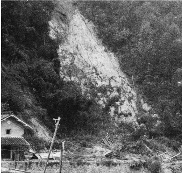
昭和47年豪雨 土砂崩れによる家屋全壊
