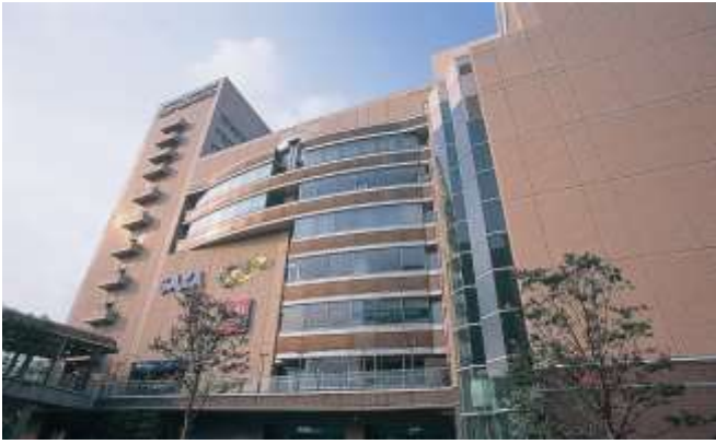
東地区再開発ビル ギャザ
